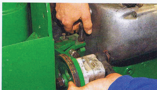
43. Die Hydraulikpumpe ist eingebaut und der Keilriemen über das Scheibenrad gelegt. Jetzt die Spannung einstellen: Er darf sich nur ...
